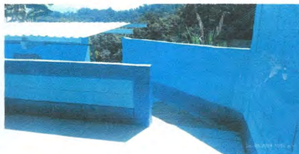
Foto 2: Mejoramiento modulo de corredor.
