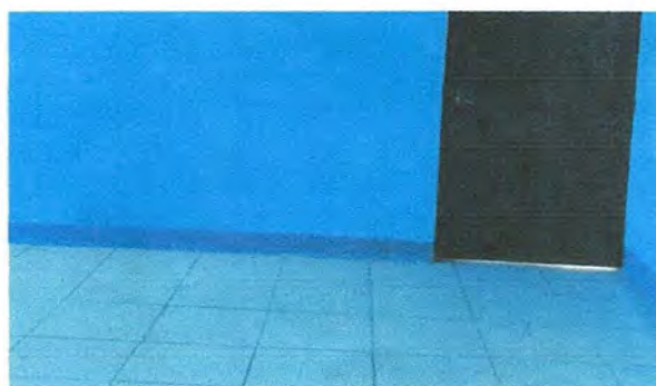
Foto 4: Mejoramiento de piso (Ceramico de alto impacto)
