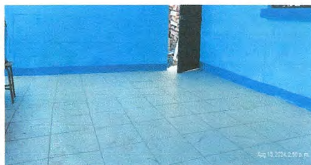
Foto 2: Mejoramiento de piso (Ceramico de alto impacto)
