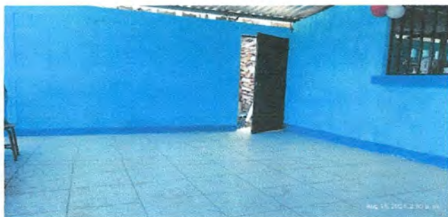
Foto 1: Mejoramiento modulo de corredor.
