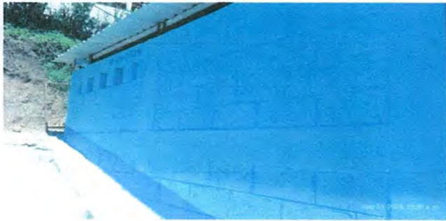
Foto 3: Mejoramiento modulo de cocina.
