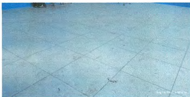
Foto 3: Mejoramiento de piso (Ceramico de alto impacto)
