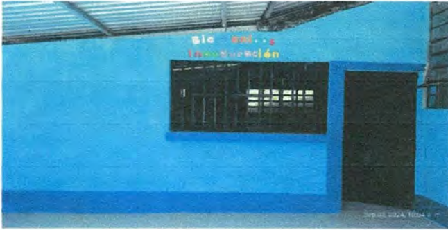
Foto 1: Mejoramiento modulo de cocina.
