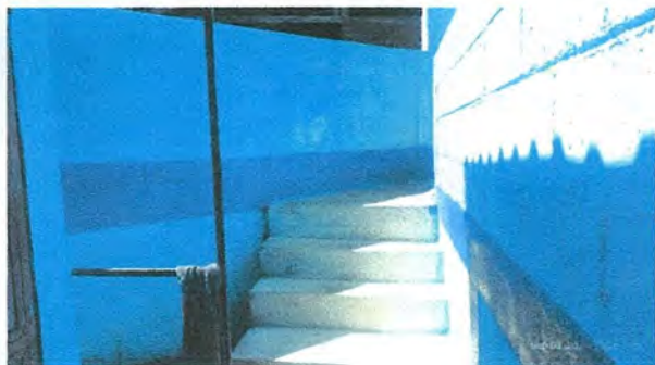
Foto 3: Mejoramiento modulo de corredor.
